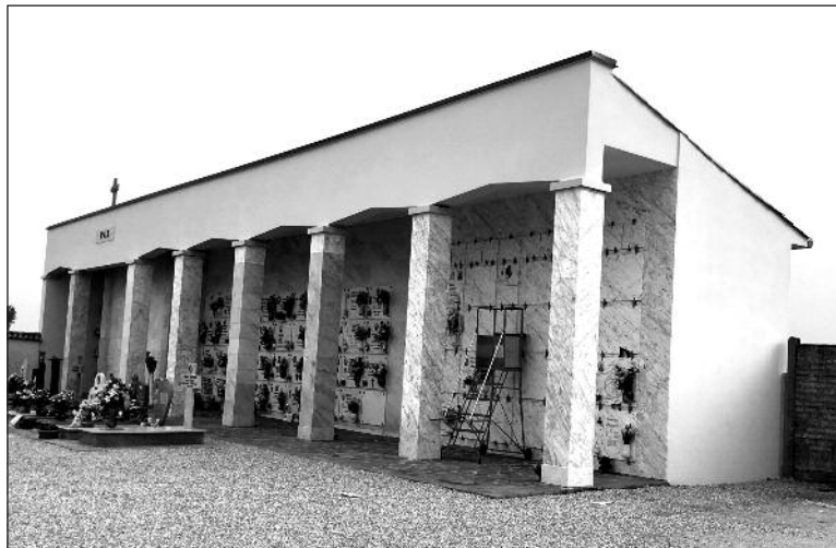
I lavori al cimitero di Pampuro
