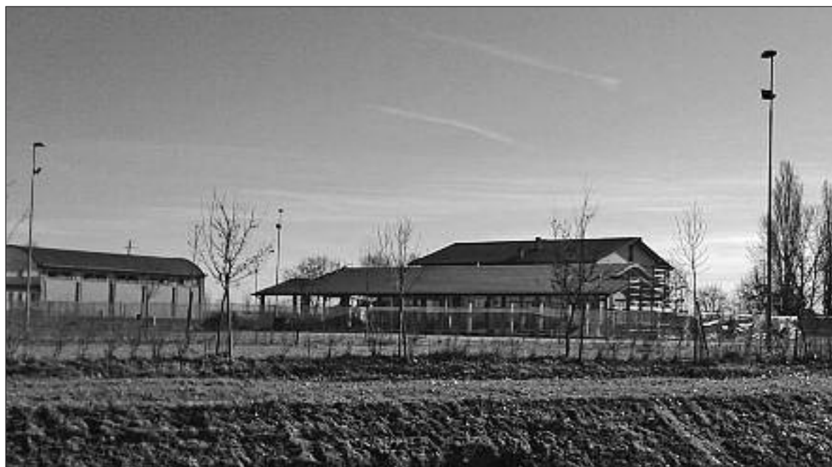
Parco della Saggina: la nuova tettoia con l'impianto fotovoltaico
