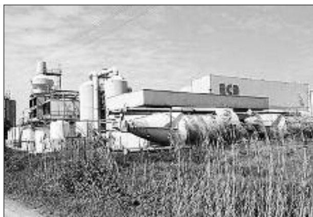
Lo stabilimento Ecb in località Sabbioni a Pontepossero di Sorgà
