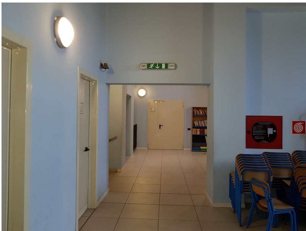
DETTAGLIO PIANO PRIMO (vista verso vano scala da compartimentare)
