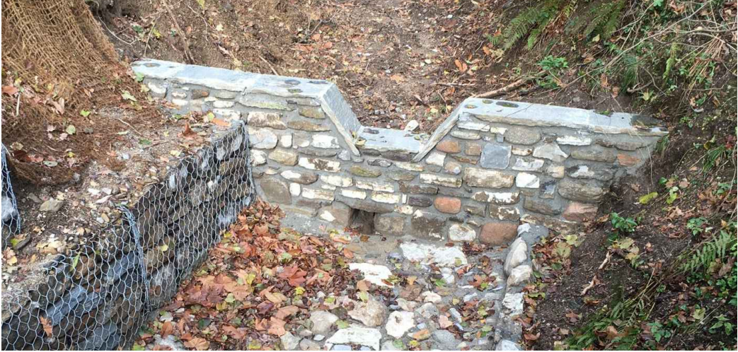
Esempio di briglia rivestita in pietrame
