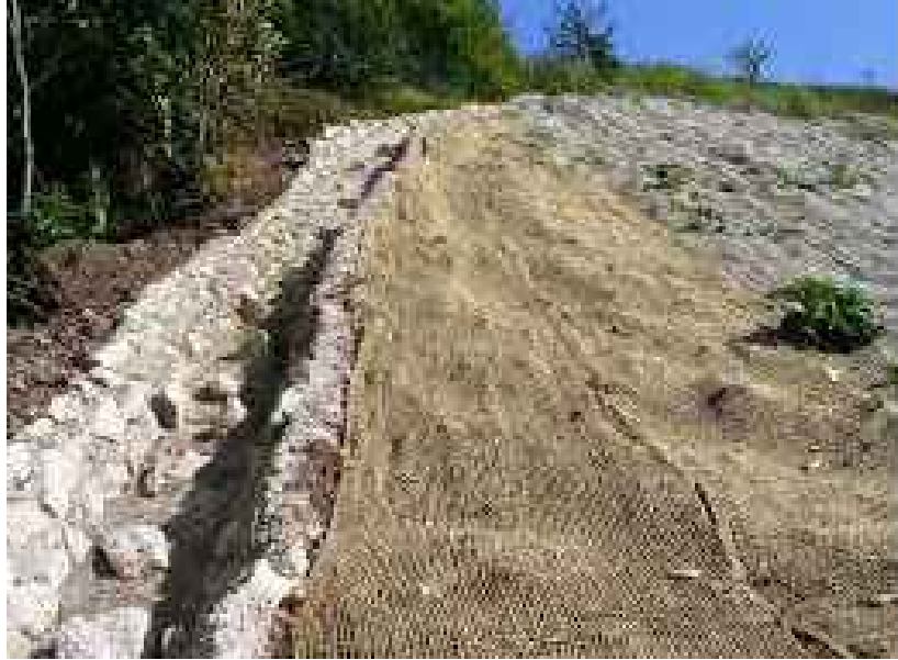
Esempio di canaletta in pietrame cementato
