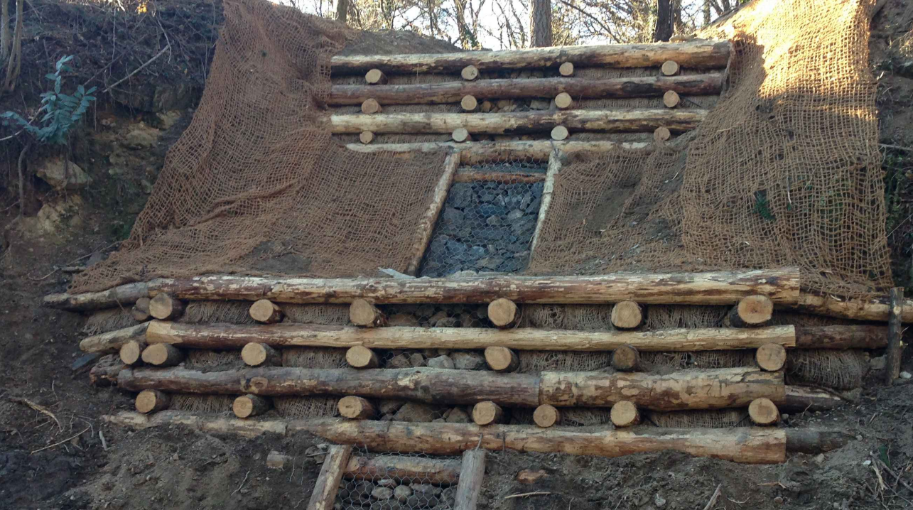
Esempio di palificata doppia su versante
