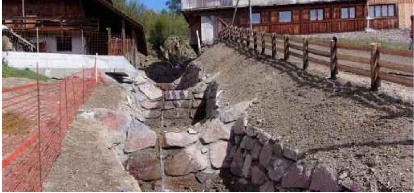
Esempio di briglia in massi cementati
