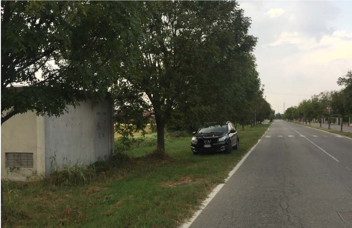
CABINA ENEL SUD
