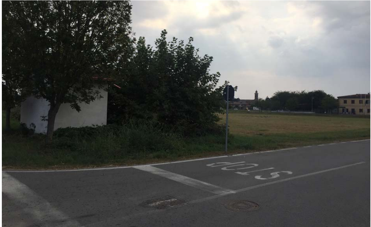
CABINA ENEL NORD
