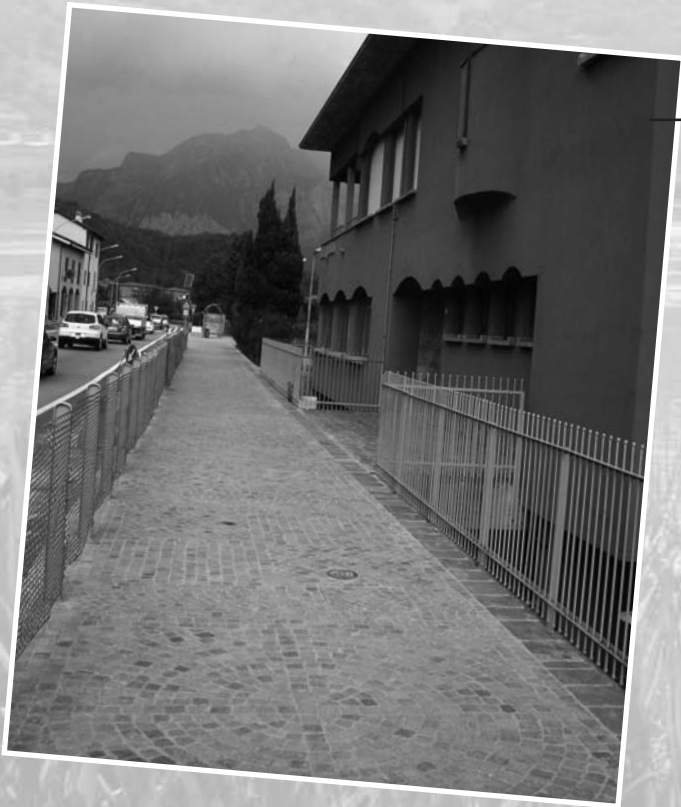
Costruzione nuovo marciapiede asilo.
